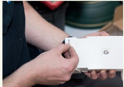
**10** Der HÜP wird mittels eines DG-Siegels verschlossen, um so Eingriffen von außen vorzubeugen. Im Anschluss erfolgt die Verbindung zwischen HÜP und dem Glasfaser-Teilnehmeranschluss (GF-TA). Dieser bildet die Glasfaser-Anschlussdose in ihrer Wohnung.
