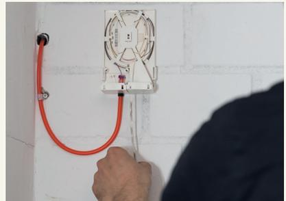
**9** Kennzeichnung des HÜP mit eigener ID. Mittels dieser kann das Gerät eindeutig identifiziert werden, beispielsweise bei der Aktivierung nach einem Umzug.
