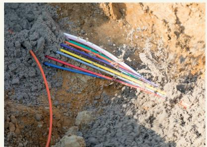
**3** Mithilfe des sogenannten Bodenverdrängungshammers unter dem Garten bzw. der Einfahrt hindurch bis zum Kopfloch an der Hauswand verlegt. Sollte der Einsatz nicht möglich sein, arbeiten wir in offener Bauweise. Die Möglichkeiten und Details sowie die Position des Kopfloches werden am Tag der Hausbegehung mit Ihnen besprochen. Vorgarten oder Einfahrt bleiben bei diesem Vorgehen unberührt.
