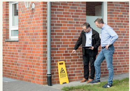
**3** Festlegung der Position des Hausübergabepunktes (HÜP), der die Glasfaser im Haus aufnimmt. Die Dokumentation der Positionen und Kennzeichnung erfolgt mittels Klebepunkten. Von außen betrachtet, befindet sich vor dieser Wand das Kopfloch.
