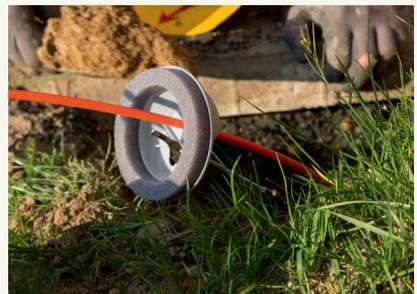
**3** Es erfolgt die Einspritzung der Abdichtungsmasse zur druckwasserdichten Verschließung des Einführungslochs.
