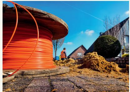
**2** Das Leerrohr – und somit die Voraussetzung für den Glasfaser-Anschluss – liegt nach dem Öffnen des Gehwegs bereits vor Ihrer Haustür. Im nächsten Schritt wird die Glasfaser eingeblasen.
