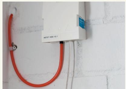
**11** Der Leitungsweg zwischen HÜP und GF-TA ist mittels Leerrohr oder Kabelschacht selbst vorzubereiten und muss am Tag der Aktivierung fertiggestellt sein. Der Weg zwischen HÜP und GF-TA darf die Länge von 20 m in Einfamilienhäusern und 30 m in Mehrfamilienhäusern nicht überschreiten. Der NT wird in unmittelbarer Nähe (0,3–0,5 m) des GF-TA installiert.
